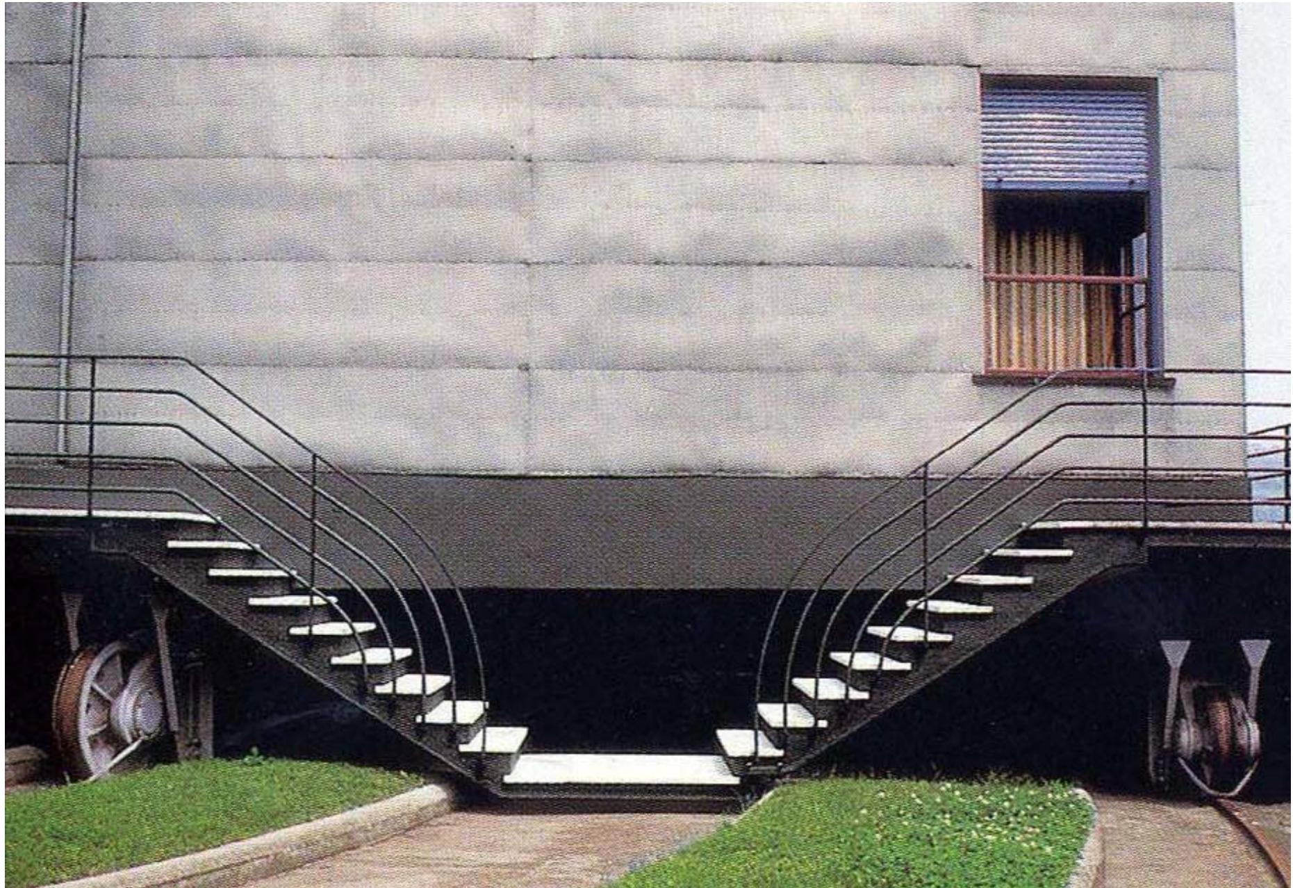
“eraklit” u vanjskom zidu alumijski lim na pročelju
