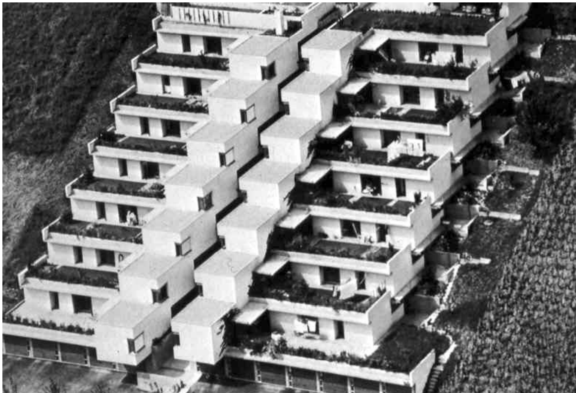
terasasta izgradnja, Untersiggental, Švicarska
